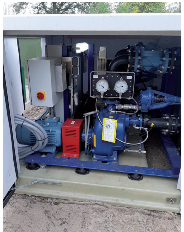
Binnenwerk opjaaggemaal.
