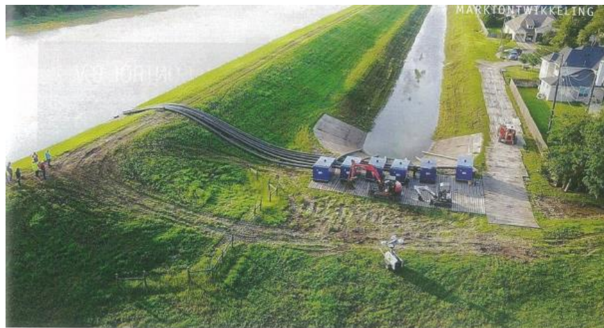
Met de S-Line biedt Gorman-Rupp een eigen alternatief voor onder meer rioolwateraanpassingen en ontwateren
