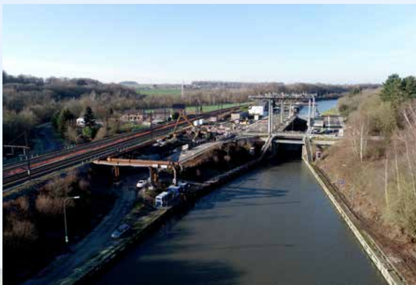
Voor een periode van bijna twee jaar heeft Gorman-Rupp in België een tijdelijk pompstation opgebouwd tijdens de vernieuwing van de vaste pompinstallatie van een sluis in het Kanaal Charleroi-Brussel.
